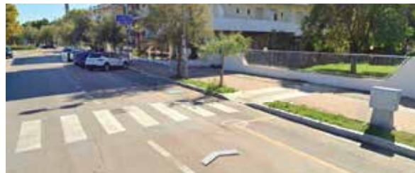
Immagine di una zona già riqualificata con la nuova pavimentazione
