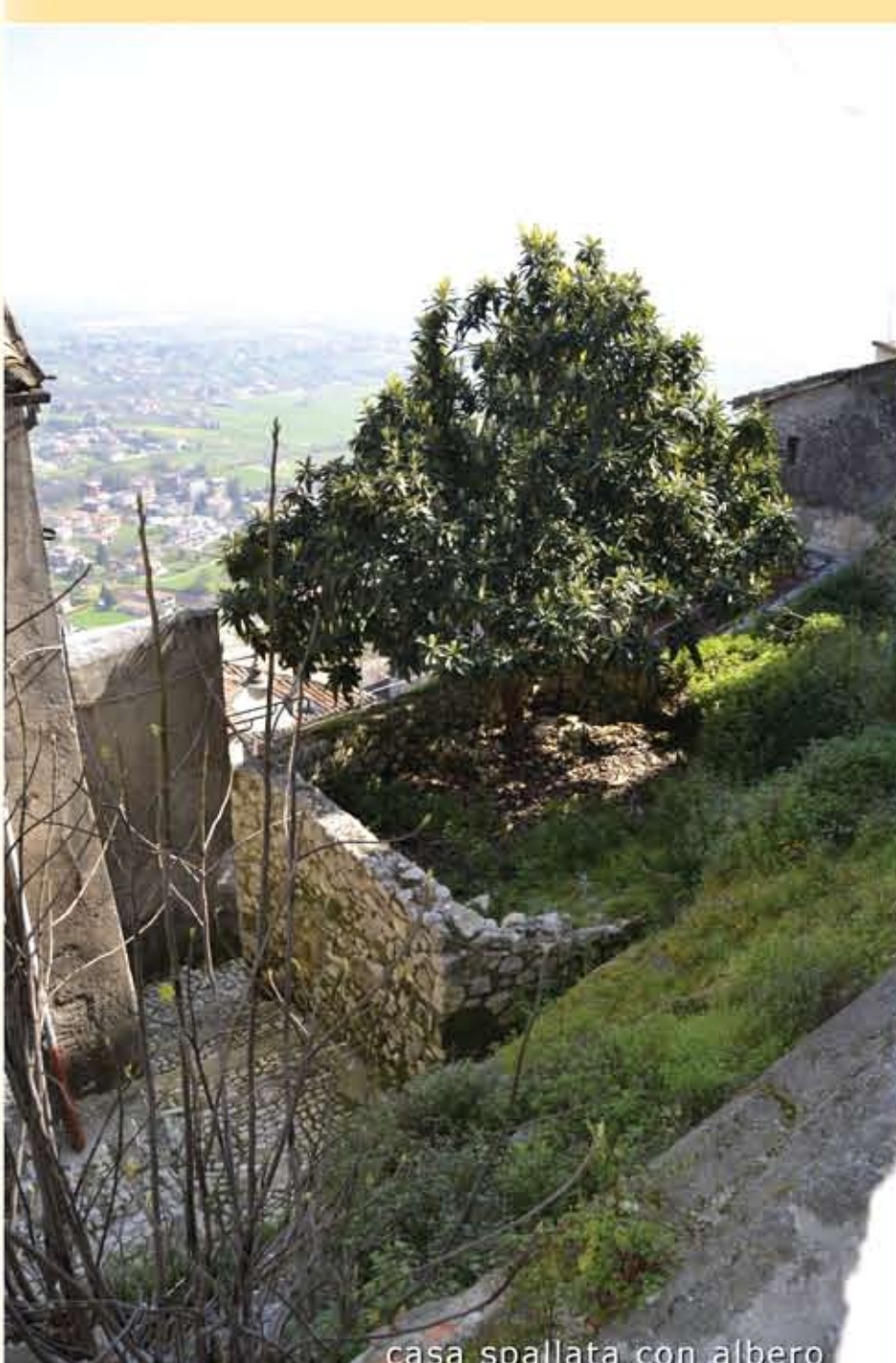
casa spallata con albero
