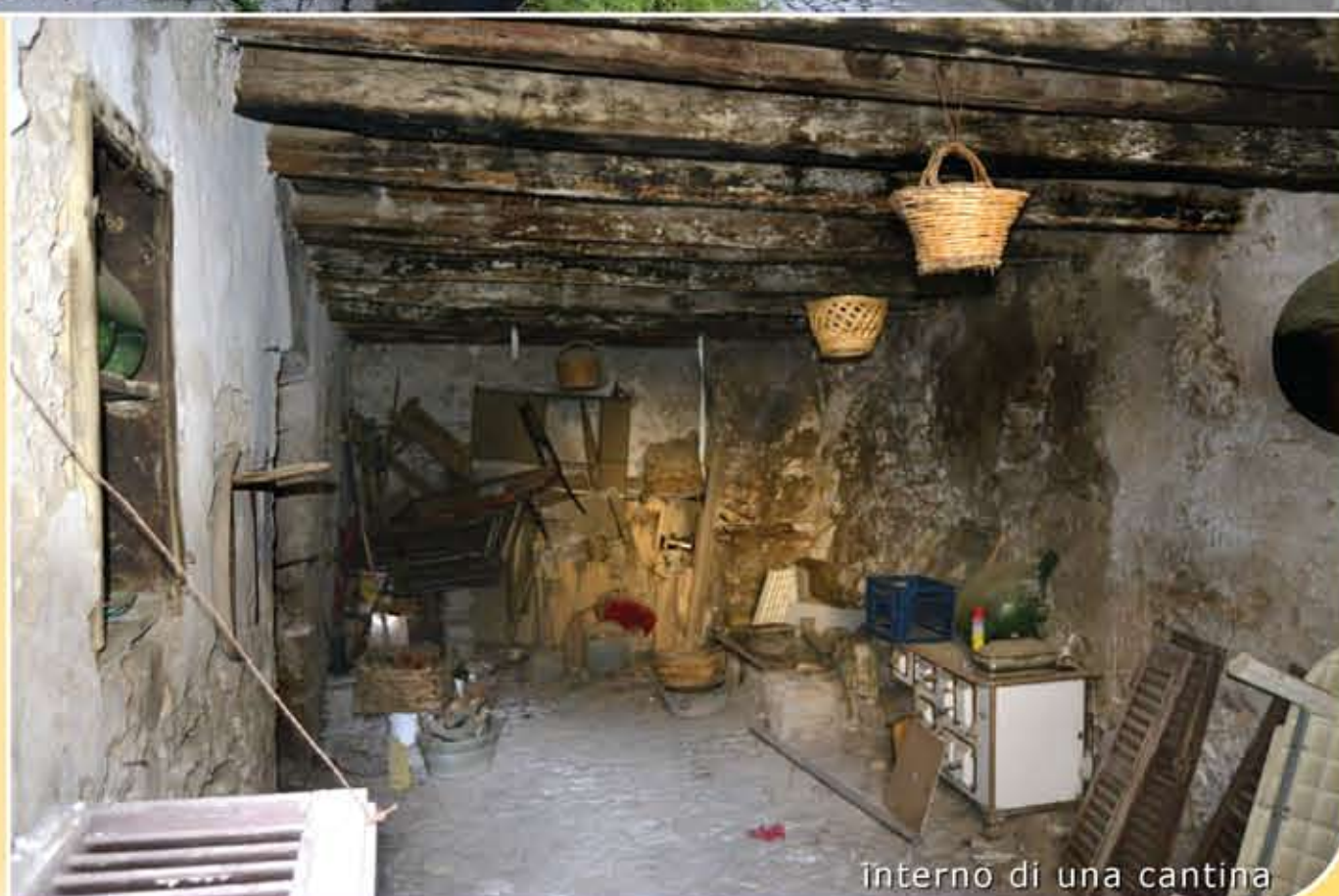
interno di una cantina
